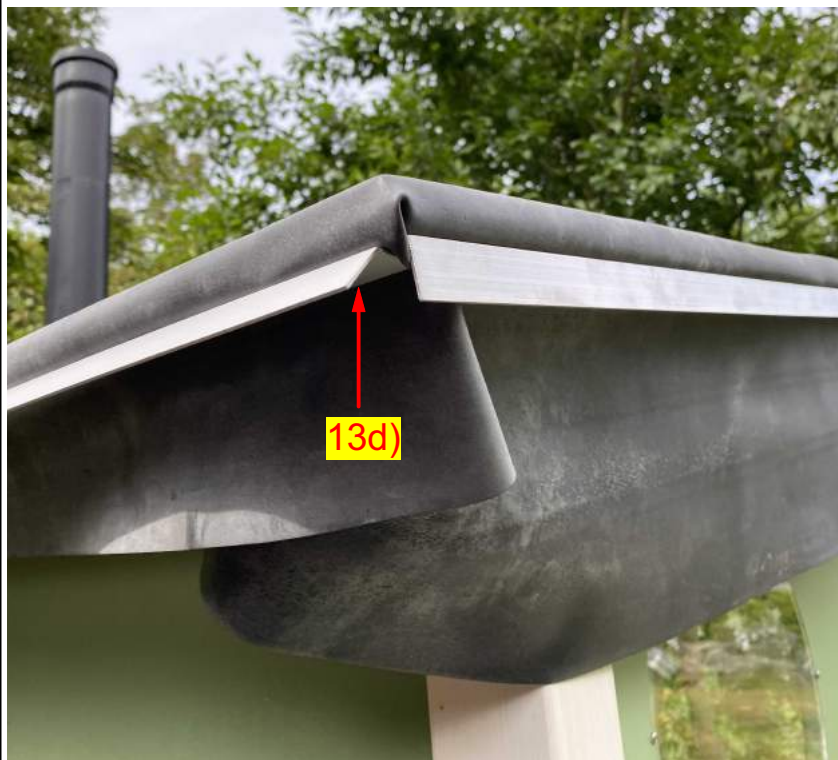
Straffziehen und festschrauben
