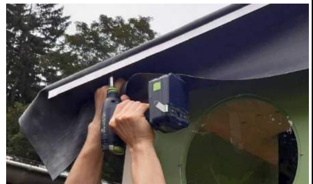
Straffziehen und festschrauben
